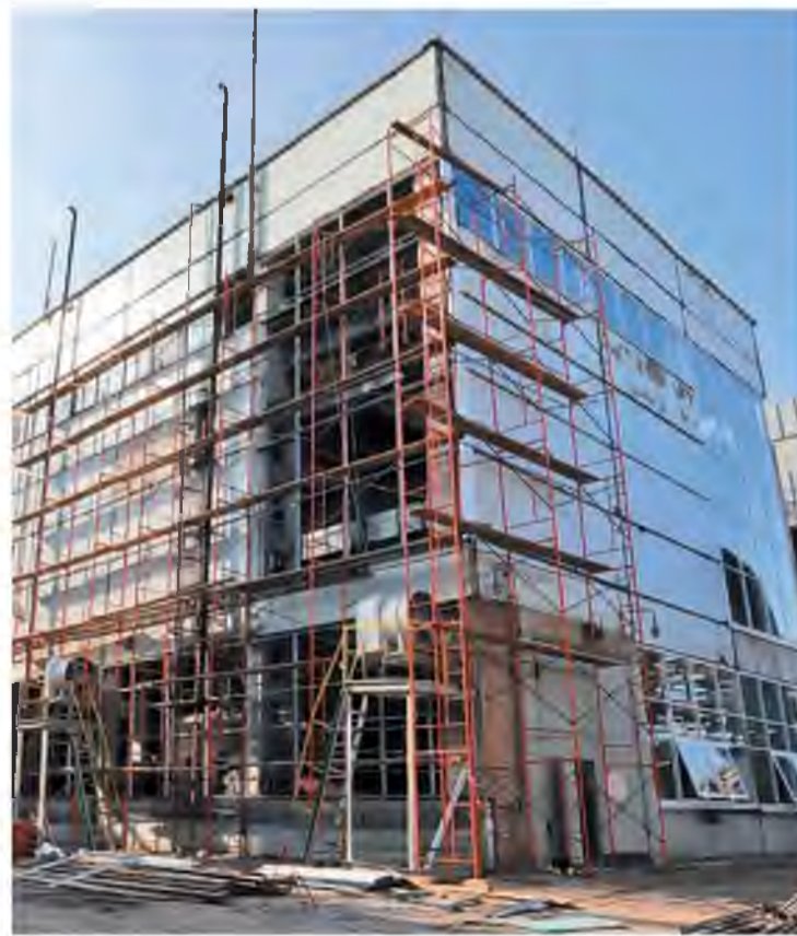
В корпусе компрессии на втором агрегате аммиака устанавливают пластиковые окна
